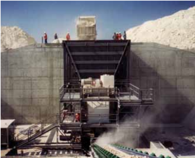
Дробилка-питатель установлена стационарно под 200 тонным приемным бункером и производит дробление известняка до крупности минус 150 мм при производительности 700 метрических тонн в час.
